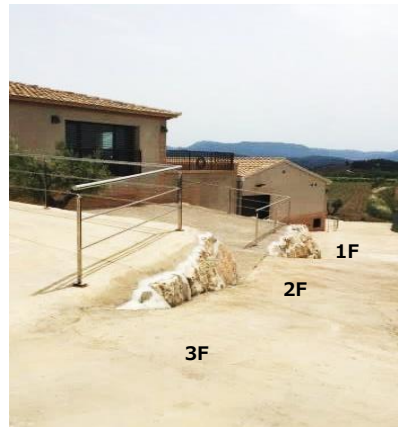
セラー横手から撮影。写真奥手が1F、手前が3Fです。他のボデガ同様、2Fまでトラックが来て葡萄を入れることができます。
