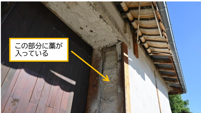
▲醸造用セラー。2013 年にアンヌと従弟のグレゴワールがドメーヌを引き継ぐと決めた年に、フレデリックが建てたものです。厚みのある壁の間に藁を断熱材として使用しています。自然素材であり、コストも節約できます。藁を入れた分厚い壁のおかげで外気が遮断されるため、温度管理が可能です。冷房は使用せず、扇風機のみで 9 月は夜間 12～13 度に温度を保つことができます。
