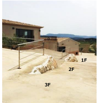
セラー横手から撮影。写真奥手が1F、手前が3Fです。他のボデガ同様、2Fまでトラックが来て葡萄を入れることができます。
