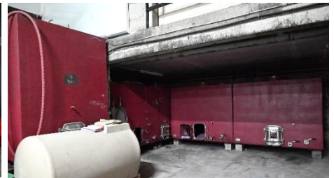
特定の赤ワイン用のコンクリートタンク
